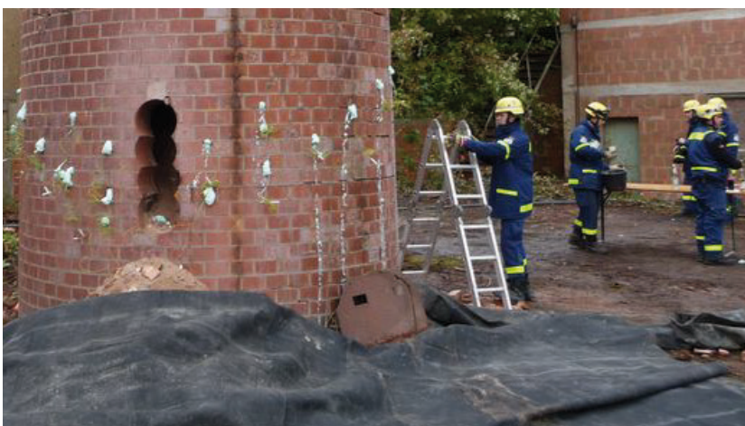
Sprengung eines Schornsteins in Neuenstein, 2009
